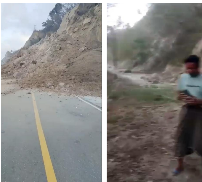
Gambar 2. Hambatan jalan akibat longsor akibat gempa bumi di Ruteng, Manggarai, NTT
